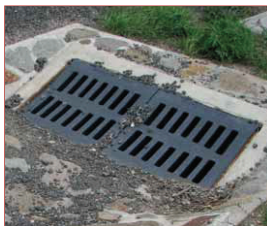
Mříž plastová s litinovým rámem C250 na horskou vpust'
